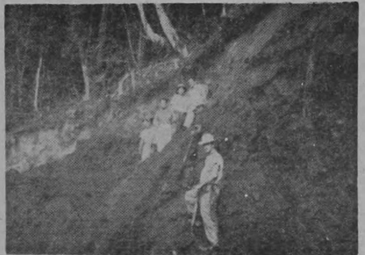
Momentos antes de que los tractors con sus últimas paladas hicieron posible la comunicación de las trochas. Entre ellos el Presidente Municipal, dos Regidores y técnicos de la obra.
